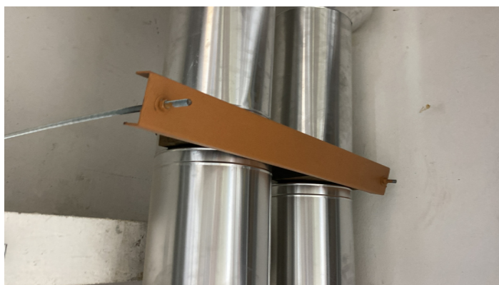
Imagem 12 - Prumada apoiada sobre escora.
