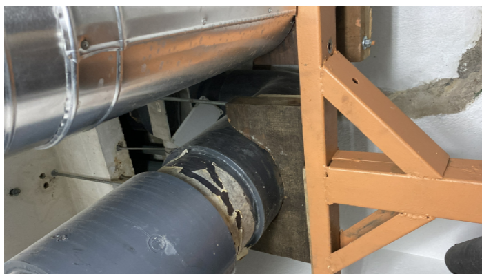
Imagem 11 - Prumada apoiada sobre escora.
