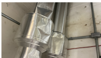
Imagem 19 - Isolamento de prumada com amassamento.
