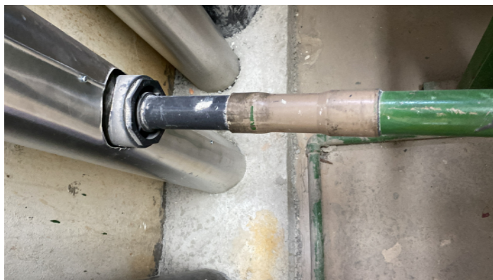
Imagem 14 - Conexão prumada PVC-U com cavalete.
